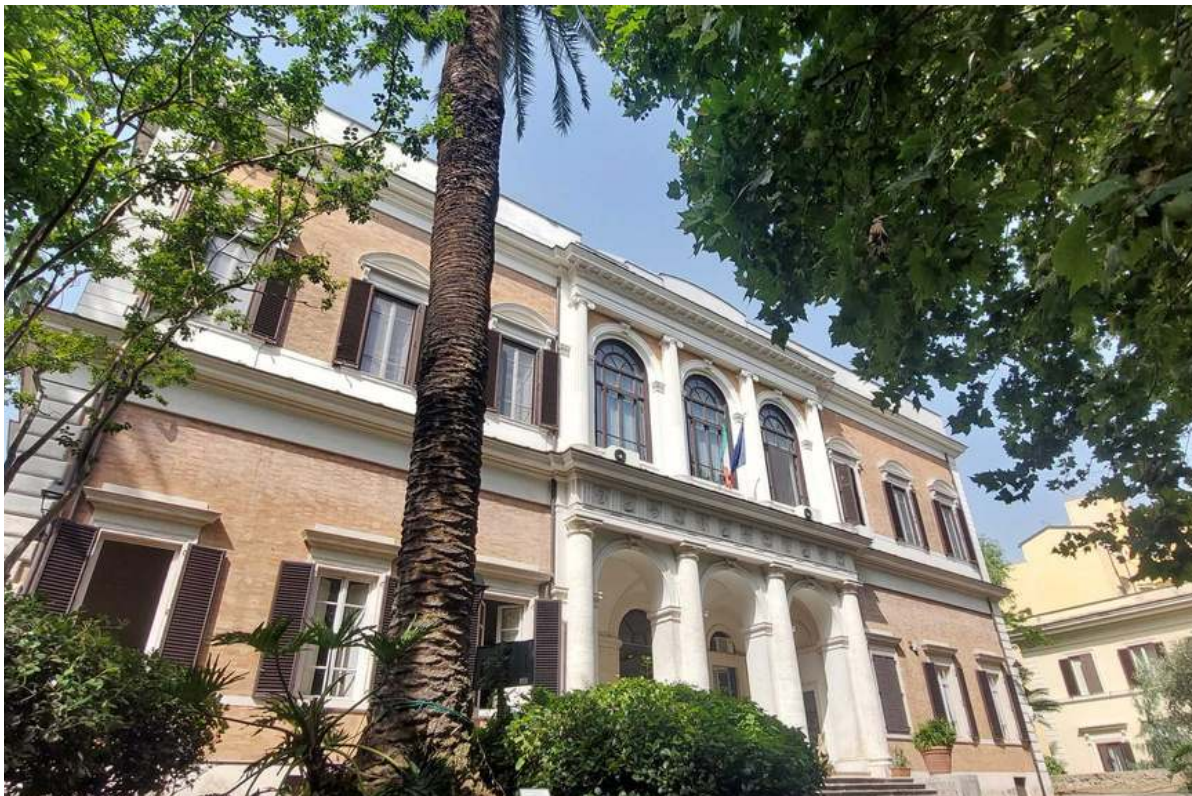
Veduta della palazzina storica dell'Istituto
